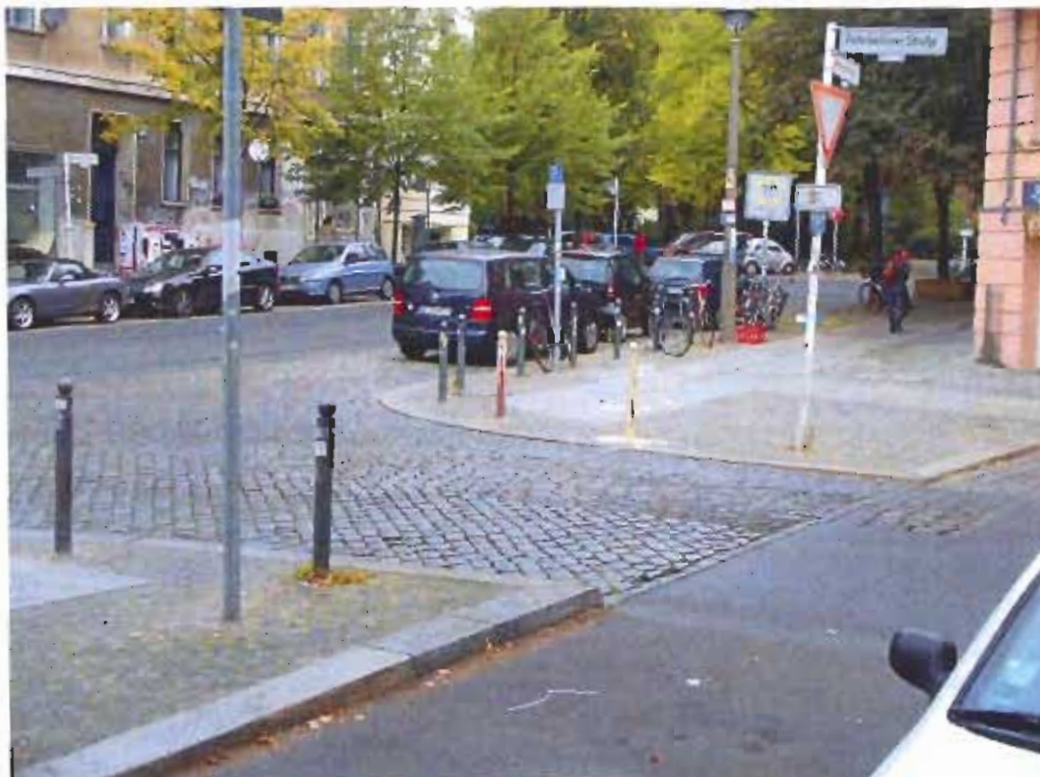
Gehwegvorstreckung Fehrbelliner Straße, südöstliche Seite
